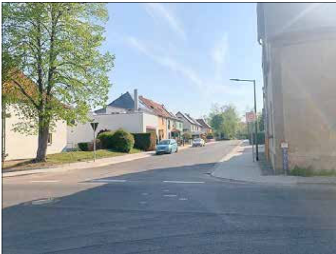
Ein weiterer letzter Abschnitt der Sanierung – Güntzelstraße erfolgt im III. Quartal 2022.
